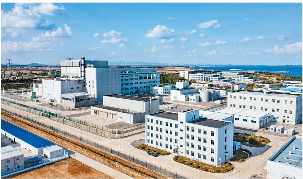
华能石岛湾高温气冷堆示范工程外景(资料照片)。新华社发
