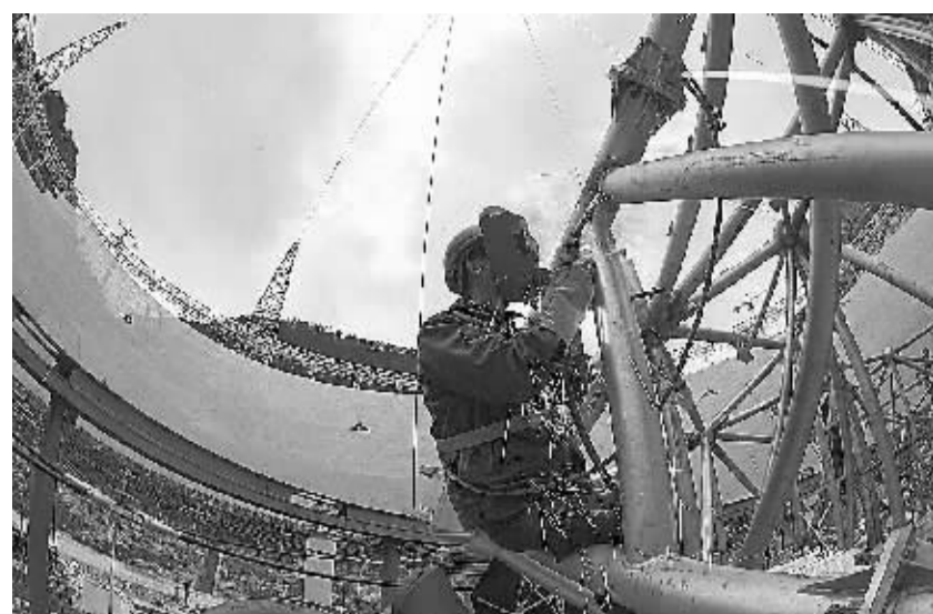
3月9日,工作人员在安装FAST工程的馈源舱。截至3月8日,正在贵州省平塘县建设的世界最大单口径射电望远镜——500米口径球面射电望远镜(FAST),已完成3492块反射面板安装,完成比例达78.47%。据悉,FAST的反射面总面积约25万平方米,用于汇聚无线电波、馈源接收机接收,预计将于2016年4月安装完毕。新华社发
